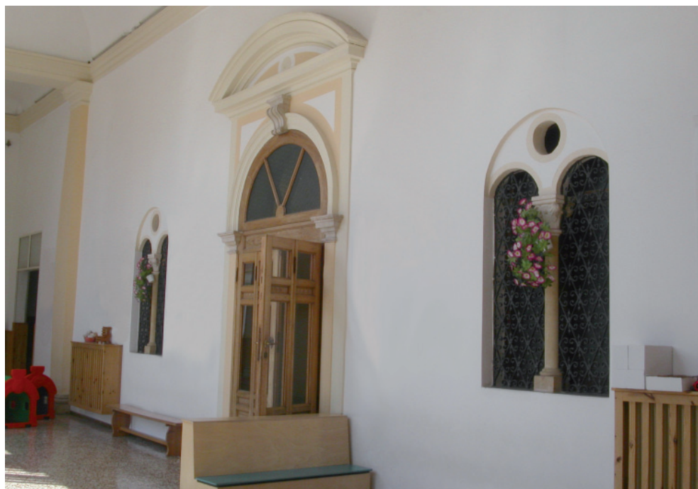
Fig. 11 Il portale interno sotto la loggia e che oggi dà accesso all'oratorio, affiancato da due bifore che testimoniano la trasformazione del primo '900 in oratorio.
